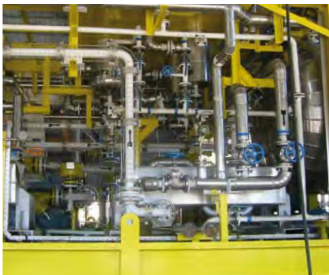
Цельно сварные теплообменники Трантер на морской платформе.
